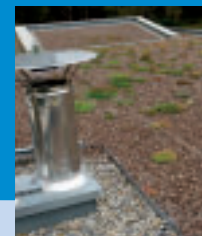
Toiture végétalisée de la crèche de Labège
